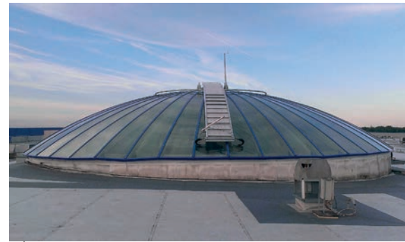
Een van de halfcirkelvormige kopeinden van de lichtstraat met op de beglazing de nieuwe onderhoudsbrug.
