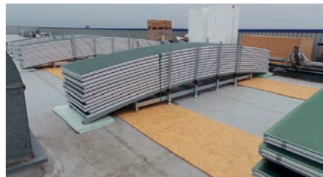
Transportrekken opgesteld op drukverdeelplaten op het dak naast de lichtstraat. Met de portaalkraan werden de cassettes uit het rek getild en naar het dak gebracht.
