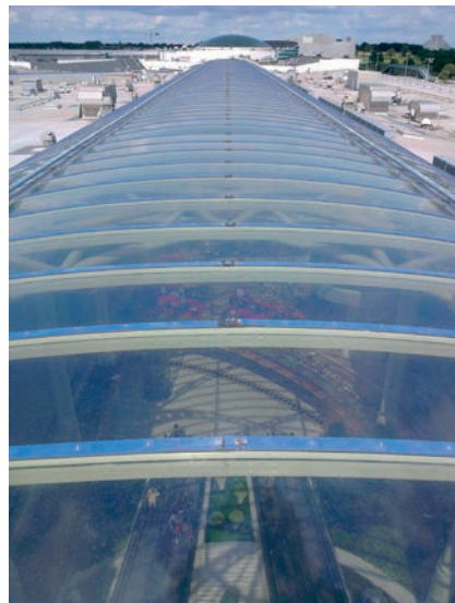
Beeld over het hart van de lichtstraat met de geplaatste cassettes.
